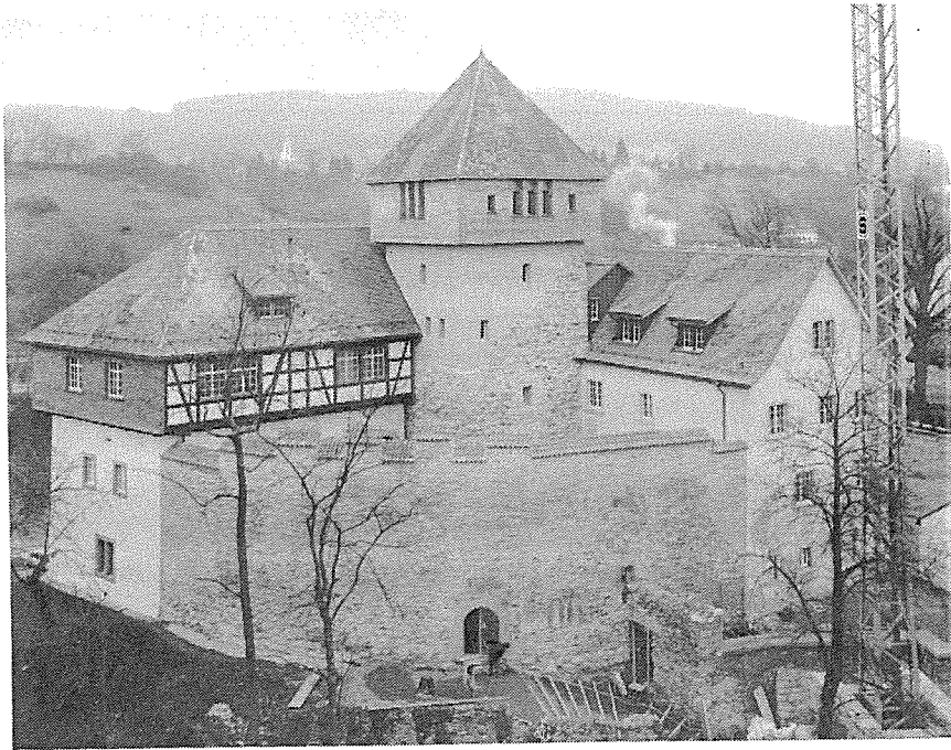
Zustand des Unterhofs unmittelbar vor Abschluss der Renovationen. Dominierend sind heute der frei rekonstruierte 1759 abgegangene Palas-Oberbau und der 1802 gekappte Oberteil des Turmes. (Aufnahme Daniel Steiner 1992). Abbildungsnachweis: Amt für Archäologie des Kantons Thurgau.
