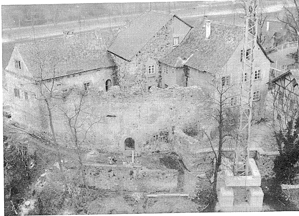
Der Unterhof mit Blick nach Norden. Im Zentrum der 1801 gekappte Megalithstein-Turm von 1186; daran gegen Osten anschliessend der östliche Gebäudeflügel von 1276/78, gegen Westen der Palas von 1318. Im Vordergrund die Ringmauer von 1217/6/78 und Terrassierungsmauern aus verschiedenen Bauepochen. (Aufnahme Daniel Steiner 1990).
