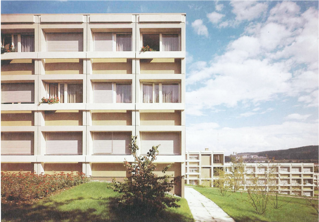
Wohnungsbau in Raumelementbauweise mit dem Variel-System. Foto: Peter Morf, Zürich, in: Jenatsch, Gian-Marco und Krucker, Bruno (Hg.). werk-serie . Fritz Stucky. Architekt und Unternehmer, Zürich 2006, S. 54.
