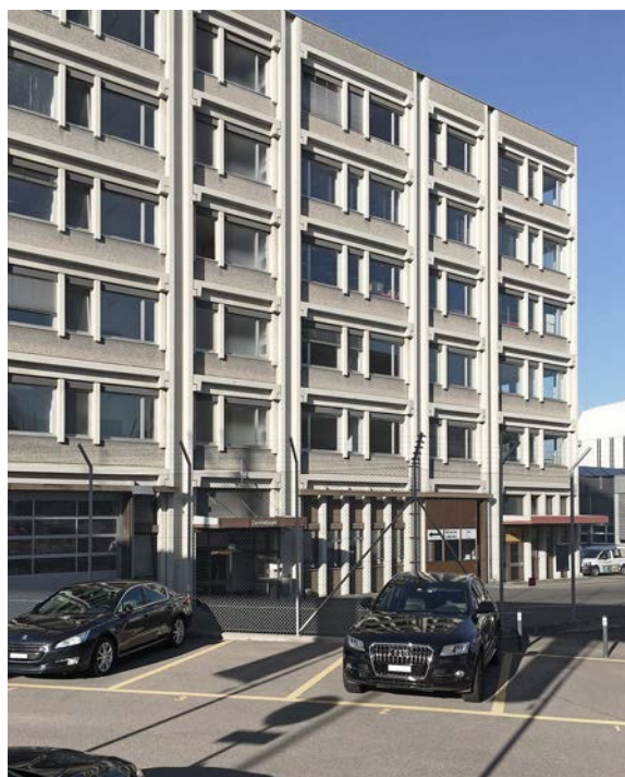
Ill. 10 Façade d'un bâtiment de Swissair à Zurich-Kloten, exécuté en système préfabriqué « Norm-Modul » de Peter Steiger.
