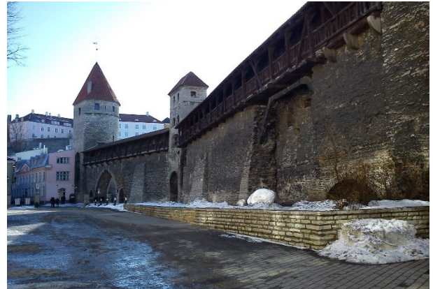
Suppression des adossements et dégagement des remparts, Tallin, Estonie.
