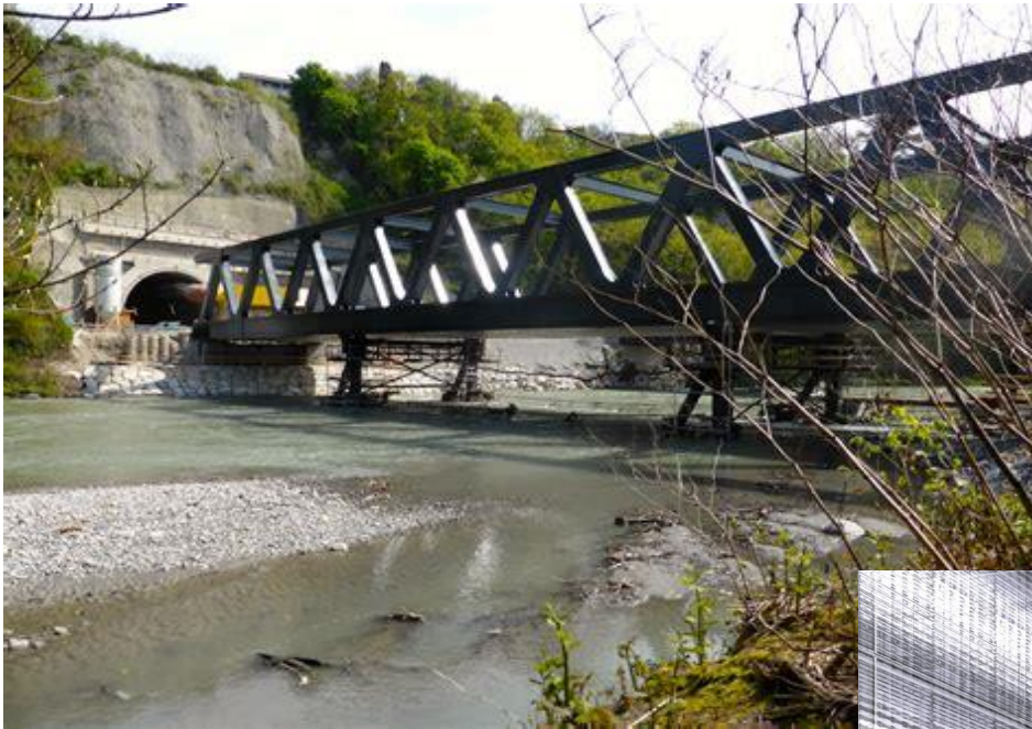
Le pont du CEVA sur l'Arve, dessiné par Jean Nouvel.
