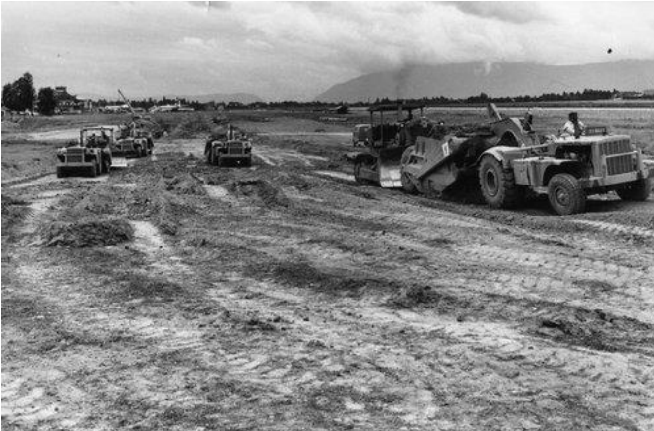
Les travaux de terrassements de la piste de l'aéroport de Cointrin, 1919.
