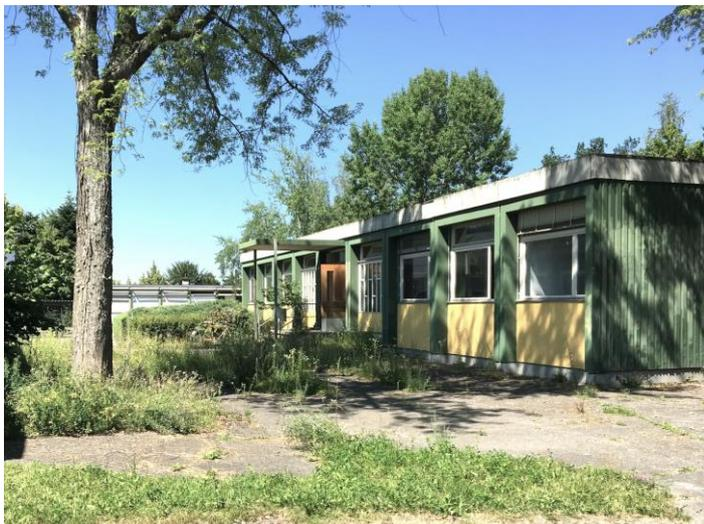
Abb 14 Das Ensemble Pavillonschule Bern Brünnen bestand aus sechs Varielbauten des Programms 63 und des Beton-Standard Programms. ©Bauart Architekten, Bern
