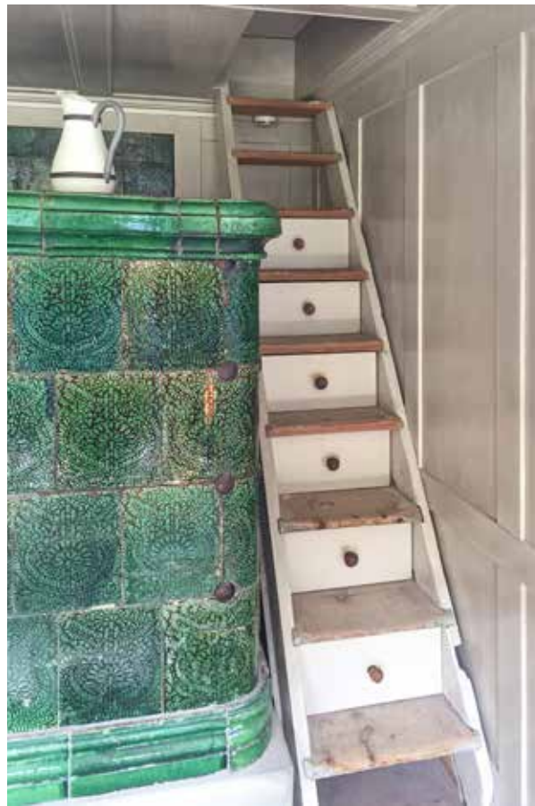
3 Durch eine «Ofentreppenlade» bzw. ein «Wärmeloch» kann die Wärme von einem Raum in den darüber liegenden geleitet werden. Ein Beispiel dafür, wie eine heutige bioklimatische Architektur von Denkmälern lernen kann. Ofentreppe Ballenberg, Haus Nummer 611 von Richterswil ZH, Foto 2019.
